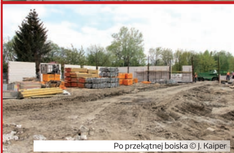
Ciągle budują © J. Kaiper
